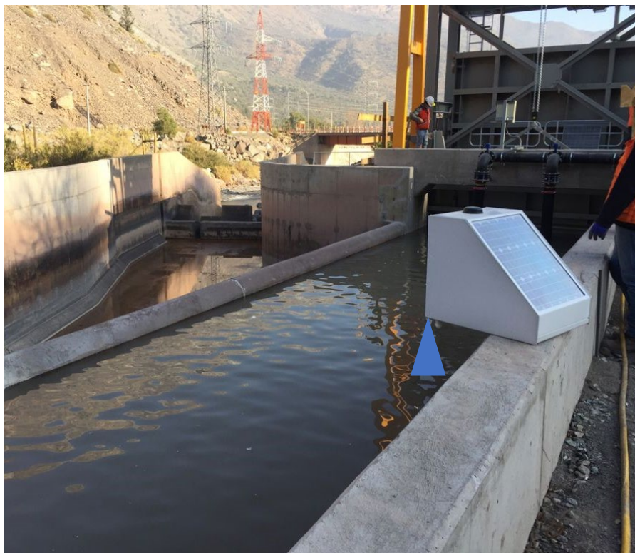
Ilustración 7 Sensor de nivel instalado en descarga Alfalfal I
